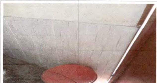
Foto 8: 13 Sustitución de azulejo
