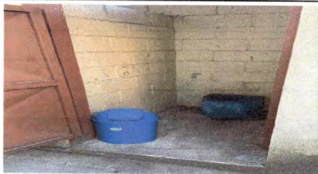
Foto 1: 10.3 Sustitución de inodoros
