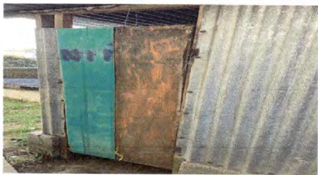
Foto 3: 1.1 Sustitución de lámina troquelada
