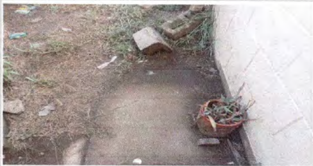
Foto 7: 16.1 Reparación de placas de concreto
