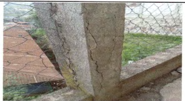
Foto 5: 15.1 reparación de muro perimetral de block, ya que por motivo de sismos, se destruyó, provisionalmente por salvaguardar la integridad física de los niños se colocó malla usada.
