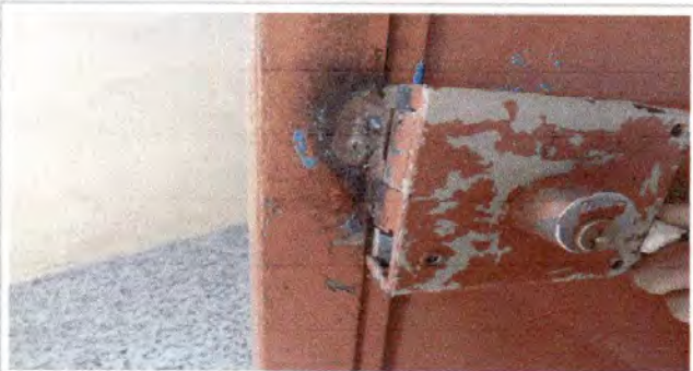
Foto 9: 4.2 Sustitución de Chapa
