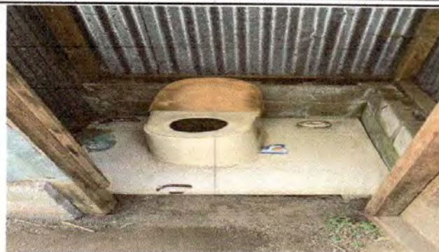
Foto 2: 10.3 Sustitución de inodoros
