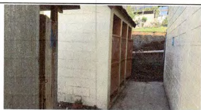
Foto 6: 1.1 Sustitución de lámina troquelada
